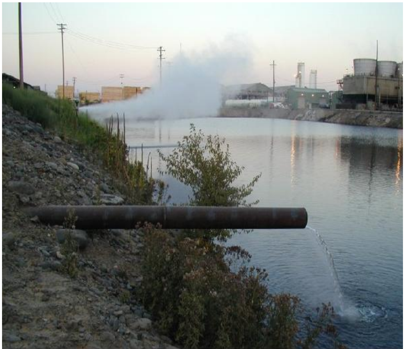
Déchargés des fours avec les unités d'Enercon Systems (premier plan). Déchchargés des purgeurs de seau (arrière-plan)
