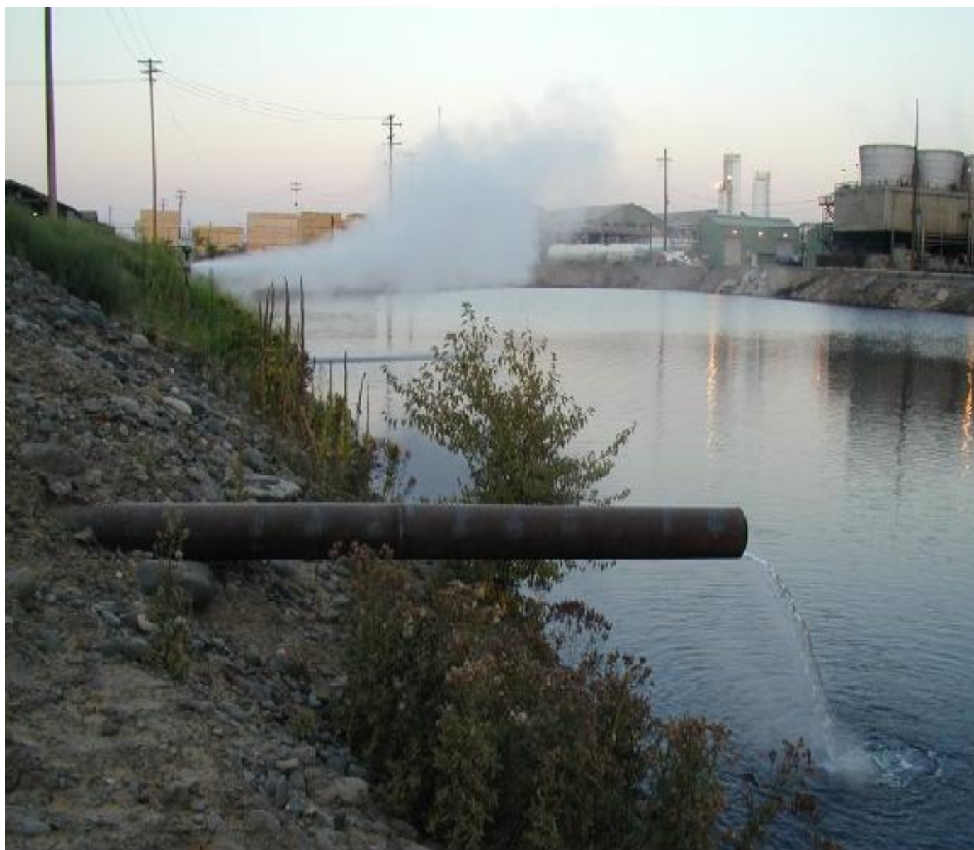
Déchargés des fours avec les unités d'Enercon Systems (premier plan). Déchargés des purgeurs de seau (arrière-plan)
